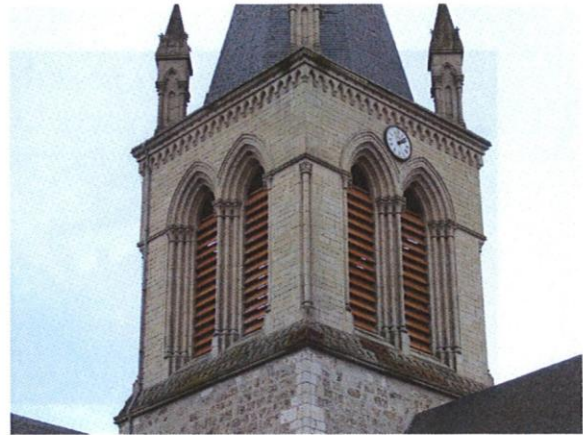
Montage et installation d'abat-sons en chêne
